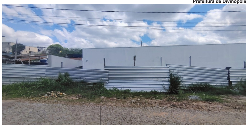
Obra da UBS Danilo Passos está em processo de retomada após impasses contratuais
